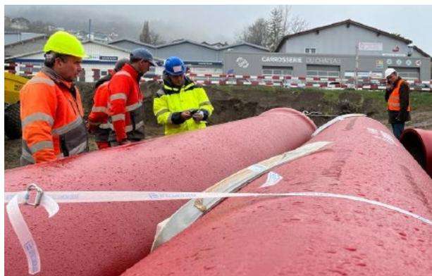
Un ingénieur d'ELECTROSTEEL DEUTSCHLAND a effectué l'assistance technique sur chantier avec présentation des méthodes sûres et efficaces de pose des tuyaux grands diamètres.
