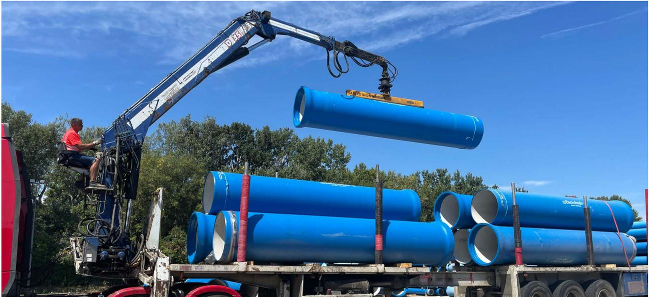
Ce sont près de 10 kms de tuyaux et raccords en fonte ductile Electrosteel diamètres 1000 mm et 250 mm qui alimenteront de façon sécurisée le secteur du CEA de Cadarache.
